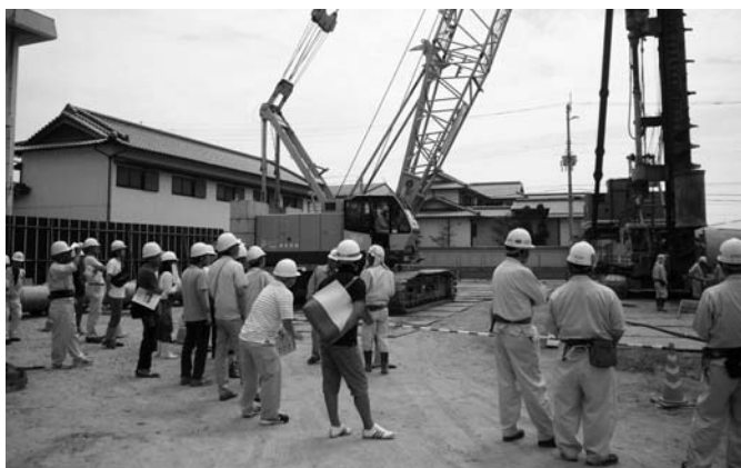
杭を建込み中
